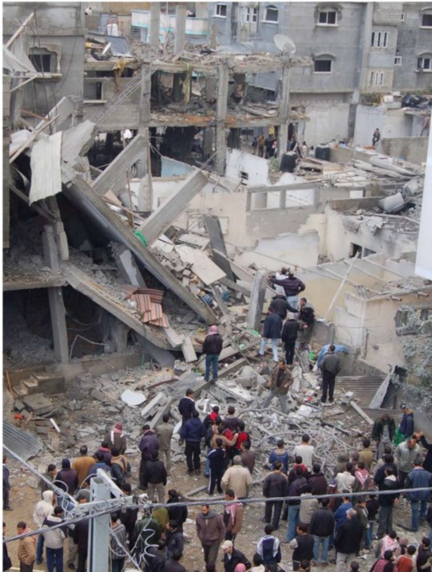
A three story building destroyed by Israeli rocket strikes, Jabalyya Refugee Camp, January 1, 2009. Over 100,000 people reside in Jabalyya's 1.4 km 2 . Photo by Sami Abu Salem مبنى مؤلف من ثلاثة طوابق في دمر هجمات صاروخية إسرائيلية. محيم جباليا للاجئين 1 كانون الثاني 2009. يسكن في المحيم أكثر من 100,000 نسمة في مساحة تبلغ 1.4 كم 2 . (مصدر: سامي أبو سالم)
